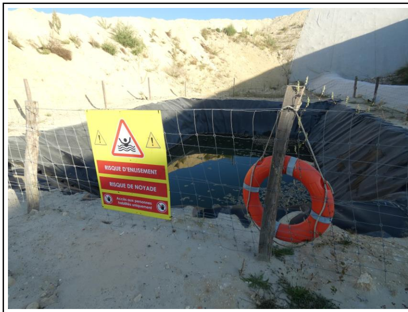
Clôture, bouée et panneau signalant les risques de noyade mis en place autour du bassin de collecte des lixiviats.
